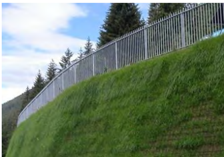
Figura 03.d: Esempio realizzativo di terra rinforzata
